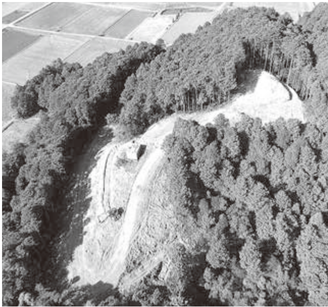
南部配水池の新設地（津村町地内）
