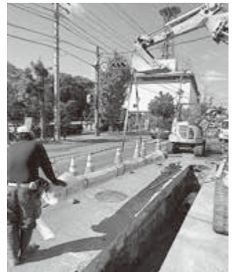
水道管の布設替え
