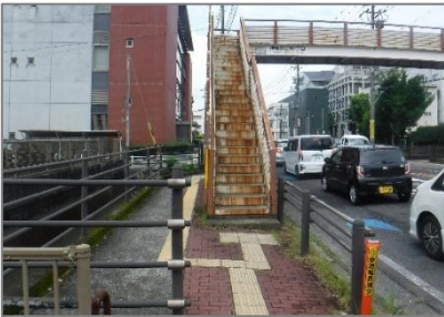
歩道橋の脚部分の歩道（右図③）
