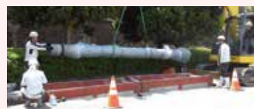
【配水本管布設替工事】
