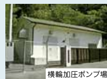
横輪加圧ポンプ場
