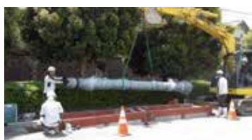
【耐震管への入れ替え】
