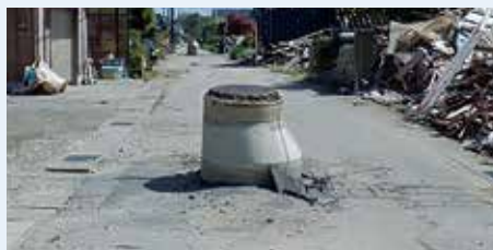
能登半島地震により、浮上したマンホール (石川県珠洲市)
