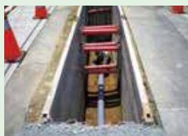
汚水管の布設状況
