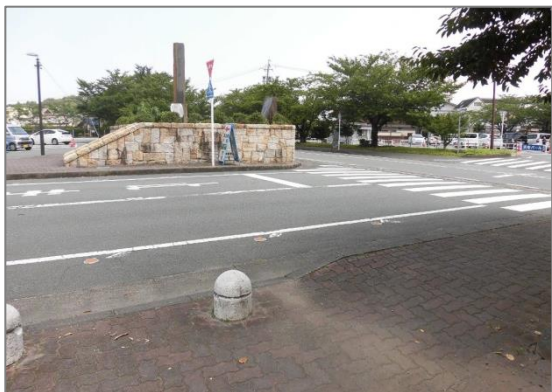
横断歩道（上左図④のうち最も北側の箇所）
