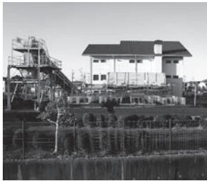
黒瀬ポンプ場
