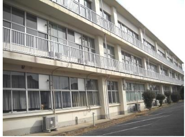
校舎外観（正面）
