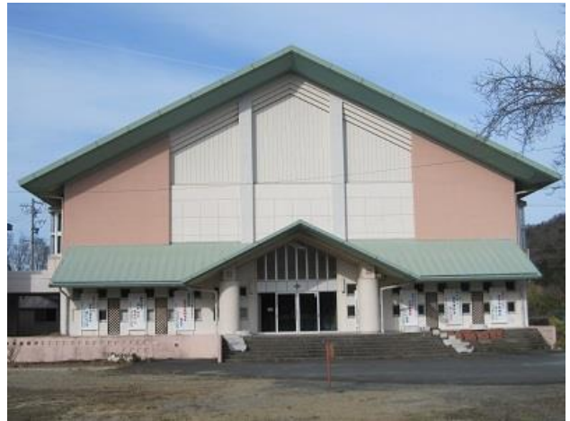
屋内運動場 外観
