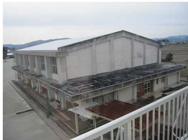
屋内運動場 外観
