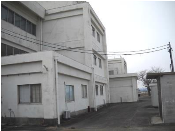
校舎外観（北面）
