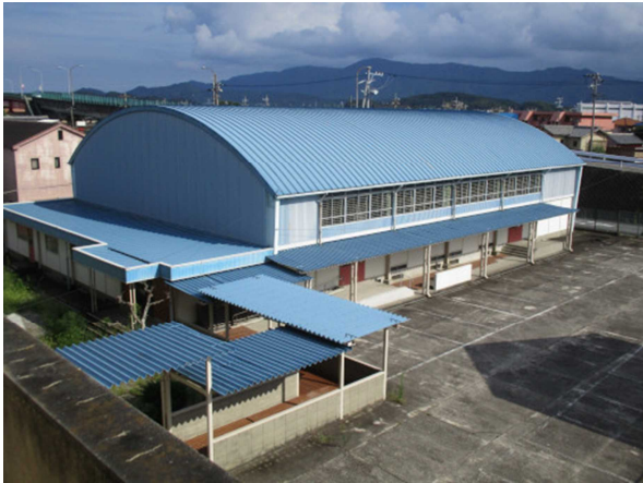
屋内運動場外観
