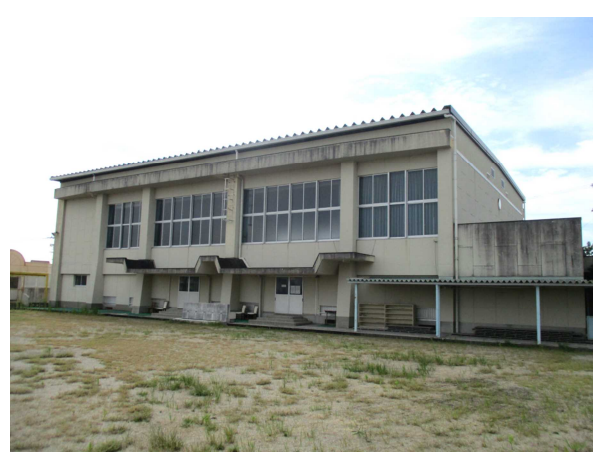
屋内運動場外観
