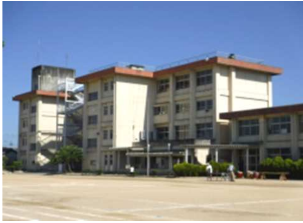
校舎外観（北側）
