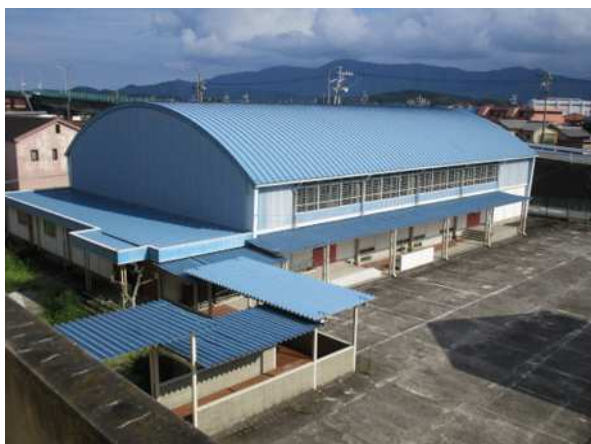
屋内運動場外観
