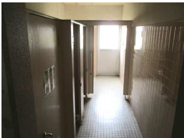
校舎1階 トイレ1
