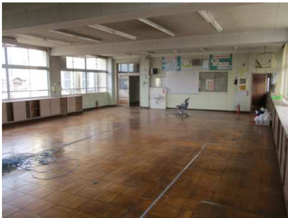
校舎2階 職員室
