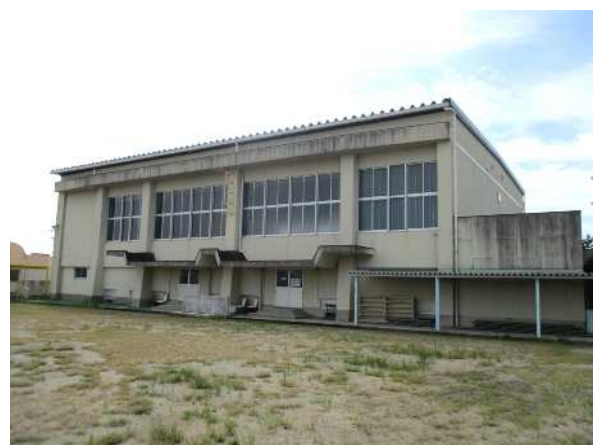
屋内運動場外観
