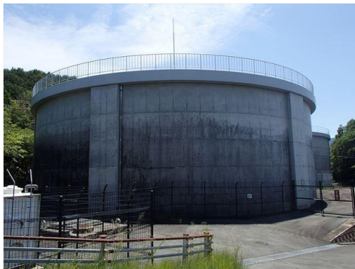
配水場(宮川配水池)
