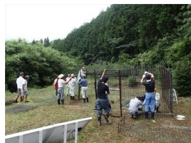
鳥獣被害対策（侵入防止柵の設置）
