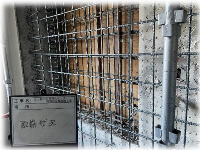
処理場耐震対策状況 (五十鈴川中村浄化センター管理棟)
