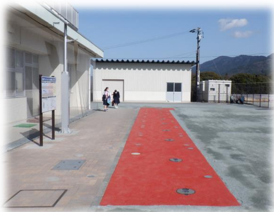
マンホールトイレシステム 設置状況(五十鈴中学校)
