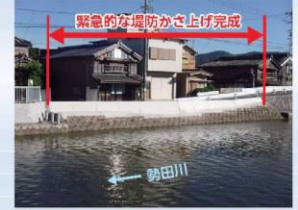
特殊堤防設置状況(北新橋右岸下流)
