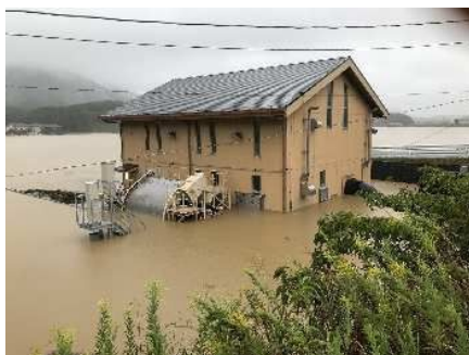
浸水した排水機場（R1.10台風19号）
