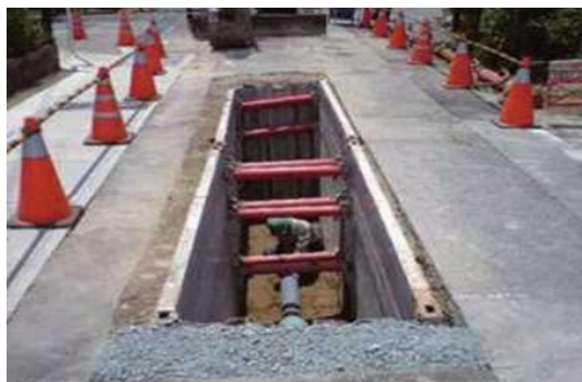
下水道管を埋める様子
