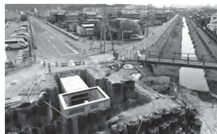
雨水排水路整備
