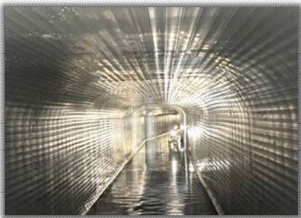
施工後の写真
