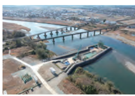
宮川橋の架け替え
