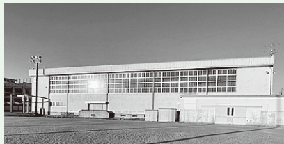
旧二見中学校の体育館を二見体育館として転用
