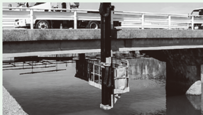
橋の修繕工事
