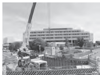
雨水排水路整備
