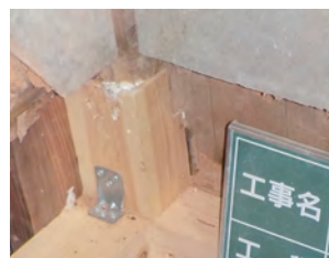
押し入れの壁などを補強し耐震化
