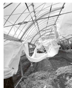
破損したビニールハウス
